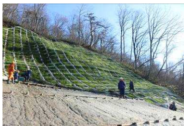
戸沢村：蔵岡地区治山工事
