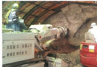
排水トンネルの掘削作業
