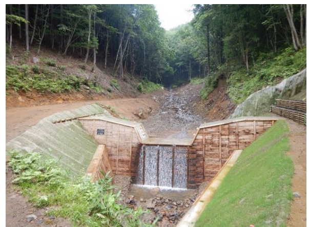
治山施設での木材使用事例 【コンクリート床固工（木製型枠パネル）】 (マエカケ沢治山工事 栗原市栗駒岳国有林)
