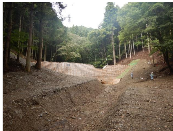
渓床・渓岸を安定化する谷止工 (石巻市 沢釜山国有林)
