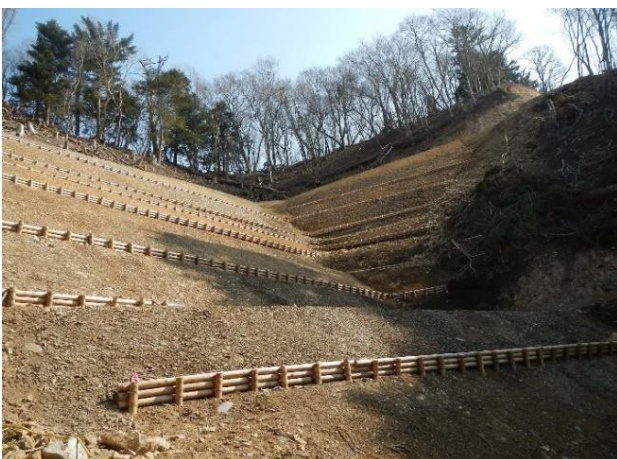
林道施設での木材使用事例 【丸太柵工（林道のり面）】 (六ノ峠林道新設工事 石巻市一ノ峰山国有林)
