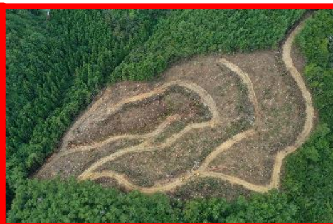
森林作業道作設状況 (南三陸町 切曾木山国有林)
