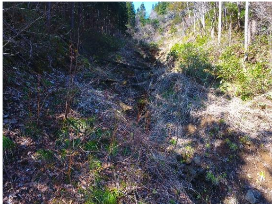
被災状況（R2年4月）
