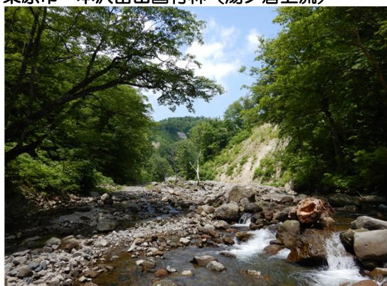
被災状況（R2年6月）
