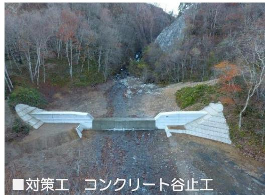
■対策工 コンクリート谷止工
