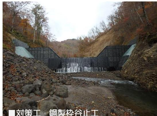
■対策工 鋼製枠谷止工
