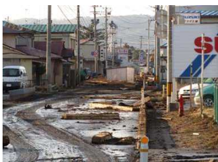
↑ 支署前の国道395号線
