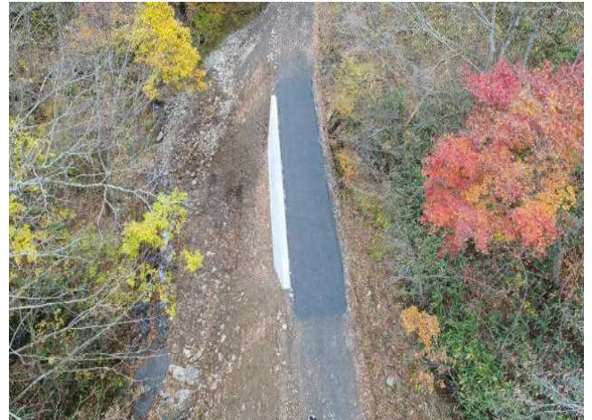
小堀内林道改良工事(R4)
