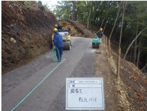
大葛越林道新設工事
