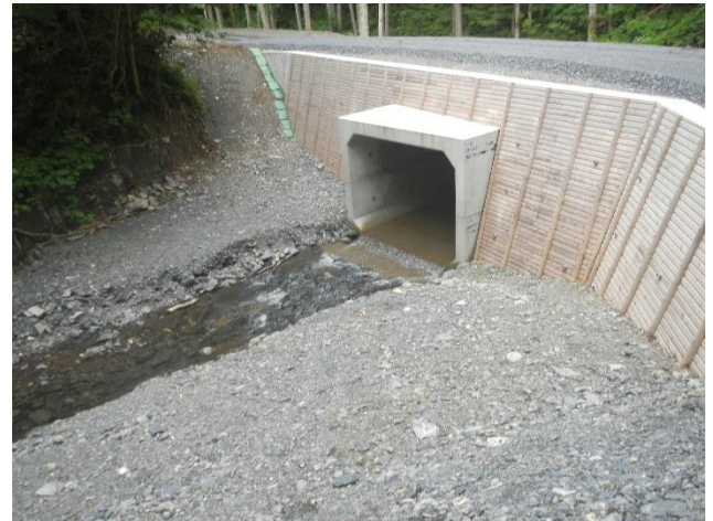
折壁林道災害復旧工事
