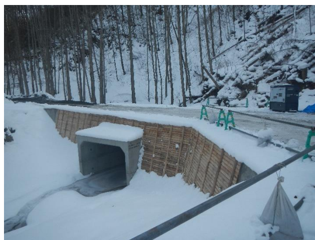
折壁林道災害復旧工事
