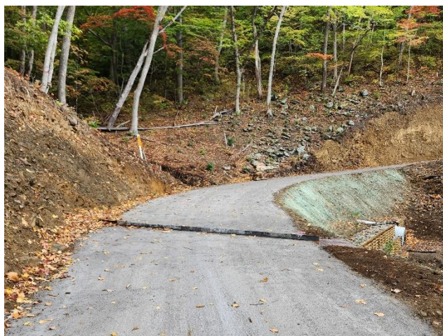
大葛越林道新設工事
