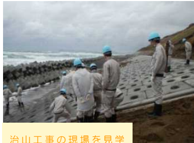
治山工事の現場を見学
