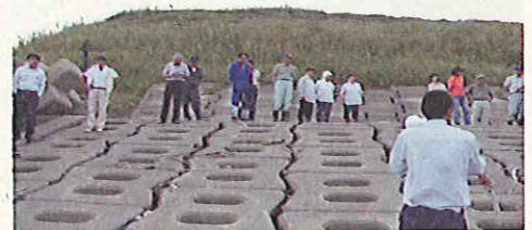
床固工事の説明
