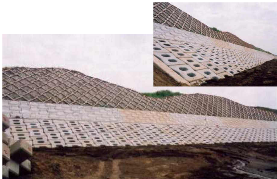
屏風山緩傾斜堤(海岸工事)
