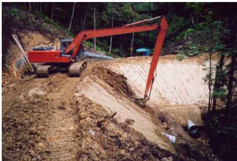
五所川原林道新設工事施工
