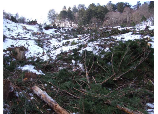
地すべり発生箇所の状況
