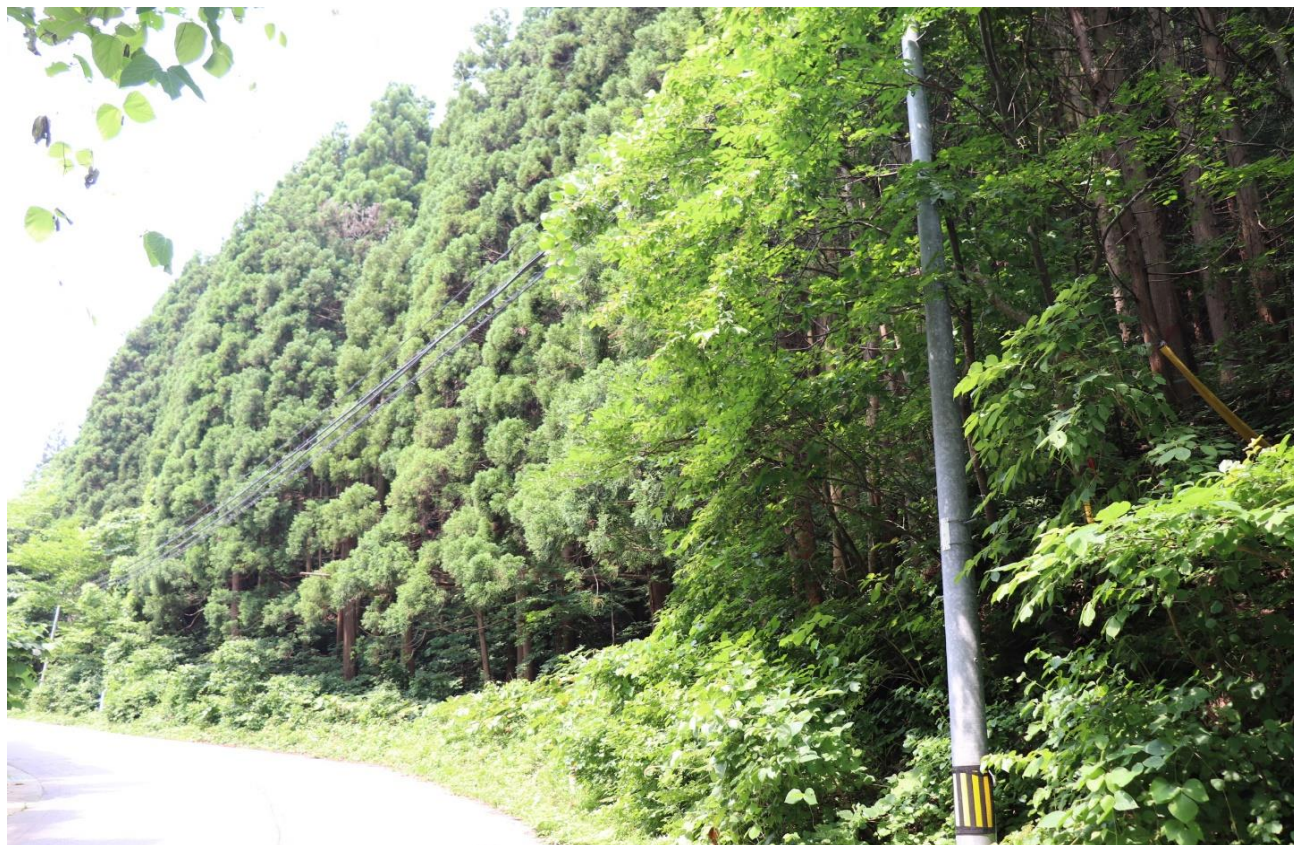
○周測番号 1 号付近（NTT電柱と電線あり）
