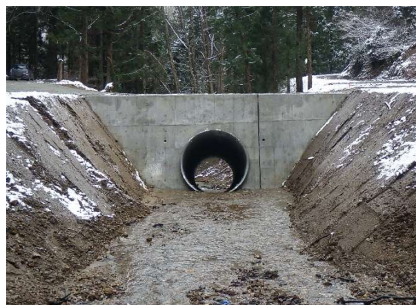
孫沢林道施工後
