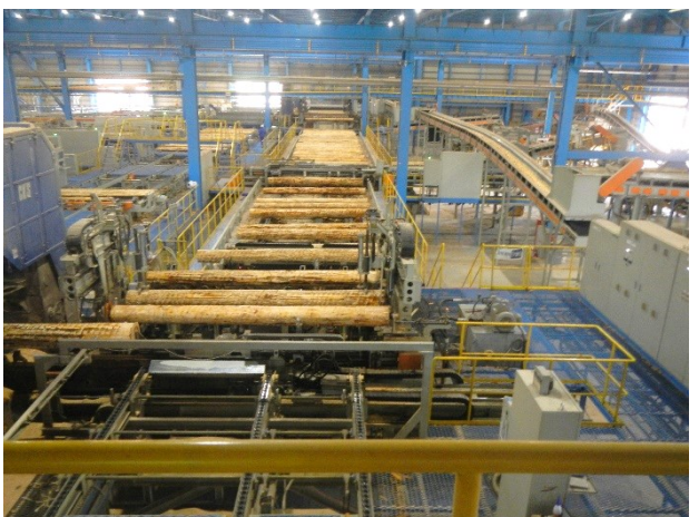
写真4：工場内の加工機稼働の一幕
