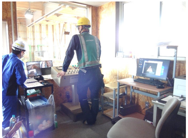
写真3：選木機の管制室
