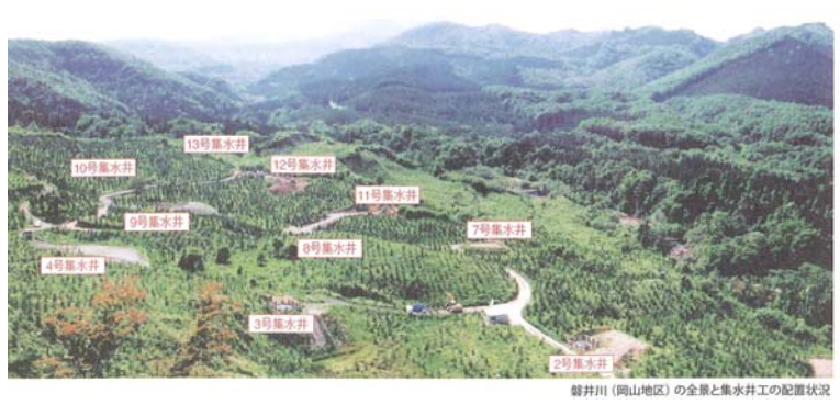
磐井川（岡山地区）の全景と集水井の配置状況
