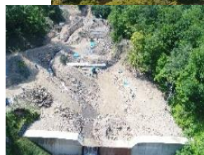
大規模崩壊・土石流が発生したエリアでの復旧に向けた取組（産女川治山事業）
