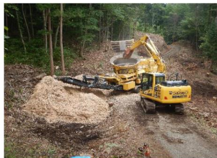
林道工事支障木のチップ化
