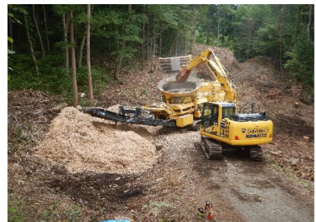
林道工事支障木のチップ化
