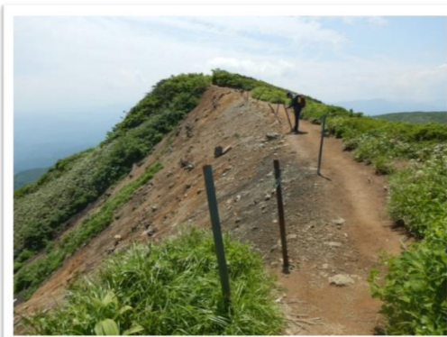
山頂から天狗平までのロープの補修
