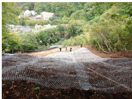
山腹工事による施設保全
