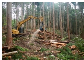
高性能林業機械による間伐
