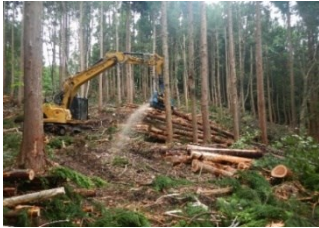
高性能林業機械による間伐
