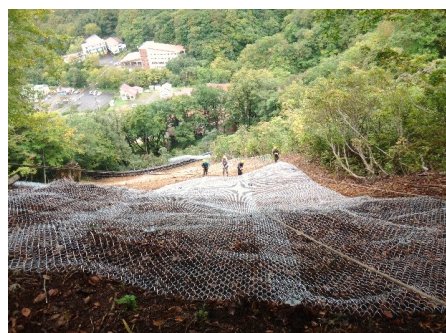
山腹工事による施設保全
