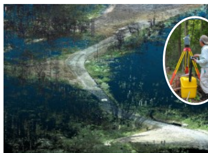
レーザスキャナー測量の実施
