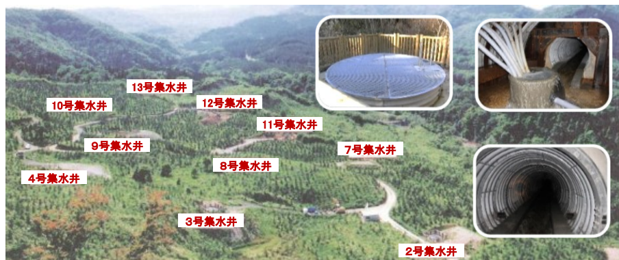
磐井川地区における地滑り防止工事の集水井工配置及び設置状況
