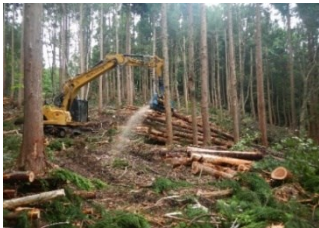
高性能林業機械による間伐
