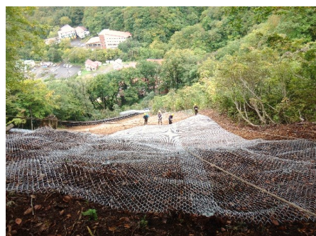
山腹工事による施設保全
