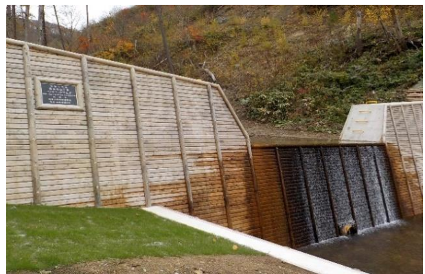
コンクリート谷止工
