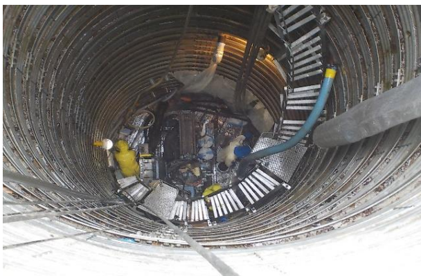
集水ボーリング工(内部)
