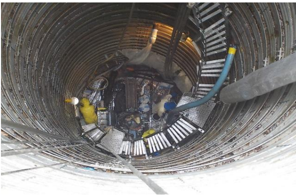
集水ボーリング工(内部)
