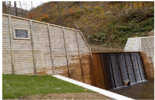
コンクリート谷止工
