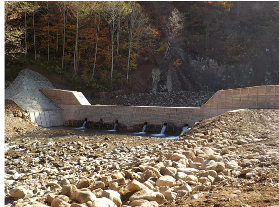
コンクリート谷止工
