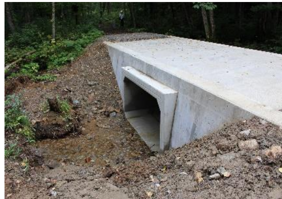
ボックスカルバート工
