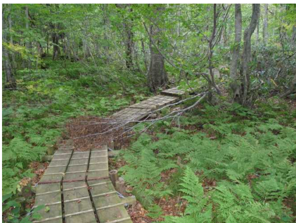
枝条が歩道上に落ちていましたので撤去しました。
