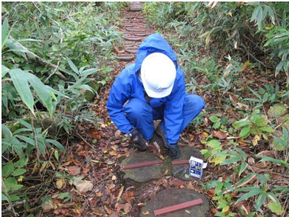
滑り止め設置の様子
