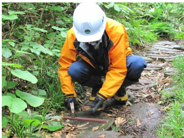
滑り止め設置作業
