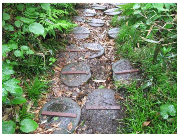
滑り止め設置後
