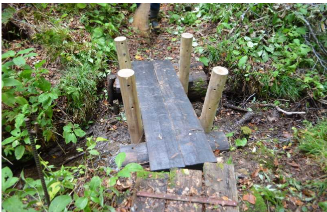
今回補修した小川に掛かる橋
