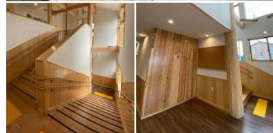
▲ 階段 (CLT材) ▲ 1階ホール (CLT材、ヒバ丸太柱)
