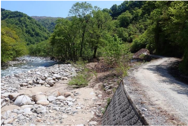
写真3 東大鳥川に近接する箇所
