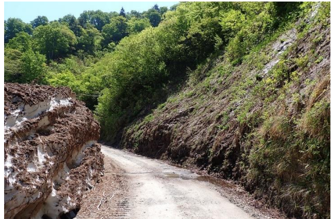
写真4 雪崩地形の岩壁と残雪状況
