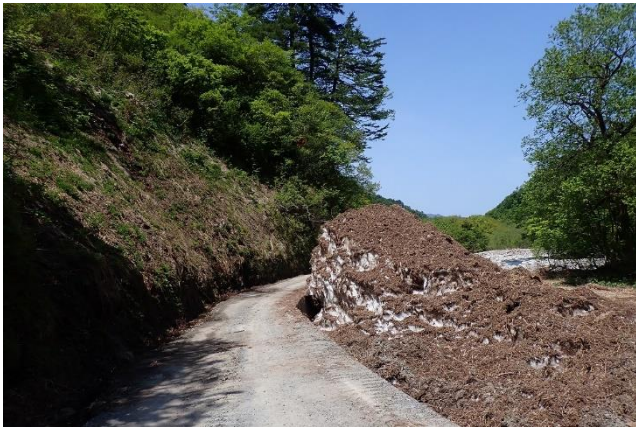
写真5 写真4を上流側から撮影
