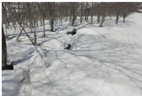
4月12日 113ち林小班地割れ状況
