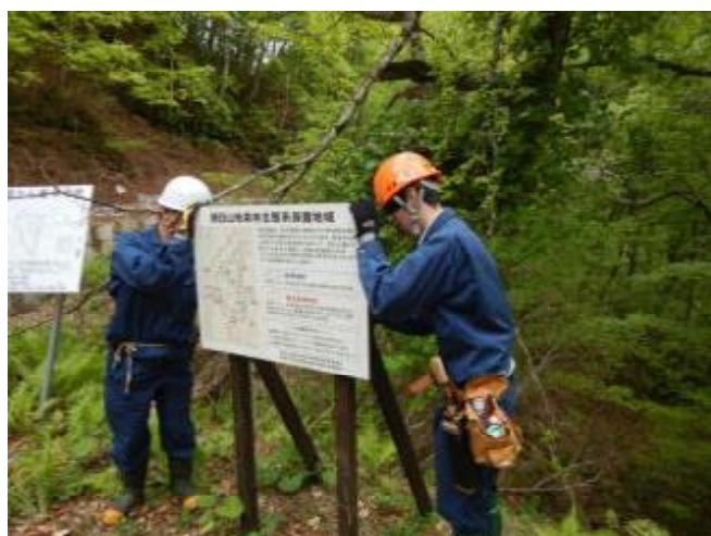
④組立式看板組立て 朝日鉱泉付近
