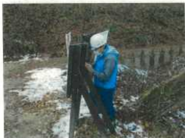
組立て式看板撤去 朝日鉱泉付近
