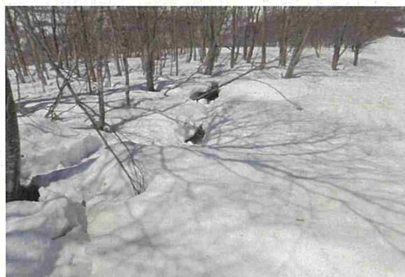
4月12日 113ち林小班地割れ状況
