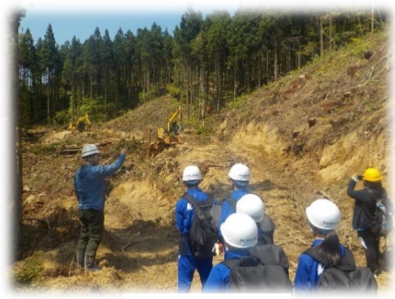
作業現場の見学
