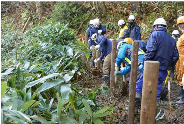
支柱の設置作業
