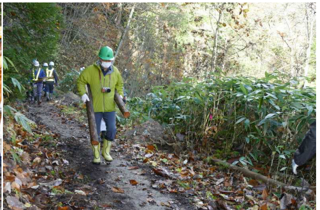
古い支柱の撤去
