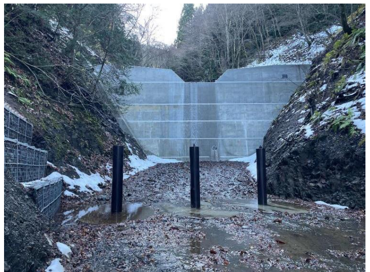
宇田沢治山工事 (外ヶ浜町)
