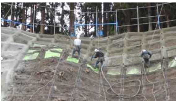
簡易吹付法砕工
