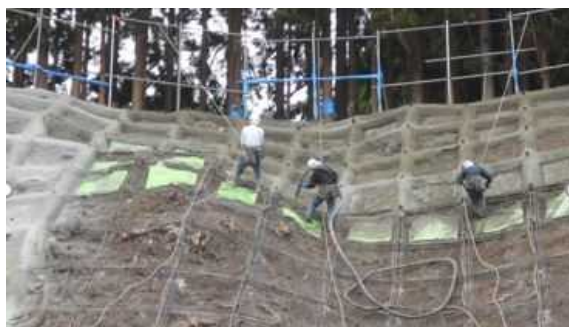
簡易吹付法砕工
