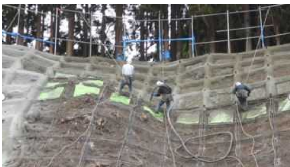
簡易吹付法砕工
