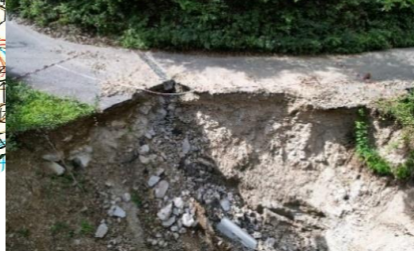
7.7km地点 道路側面崩落 L=16.4m
