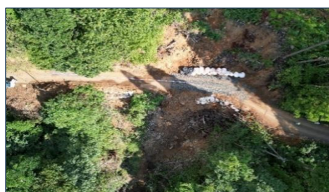
仁別林道起点から1.4km地点 (以降同じ) 道路側面崩落 L=47.0m
