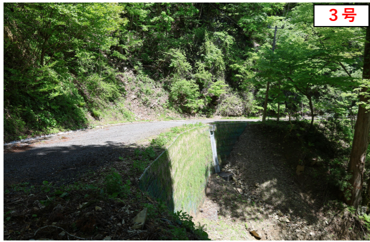
6.8km地点 道路側面崩落 L=30.0m
