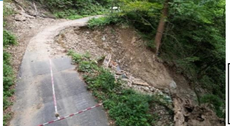
6.8km地点 道路側面崩落 L=30.0m
