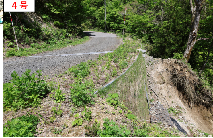
7.7km地点 道路側面崩落 L=16.4m
