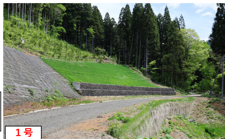
仁別林道起点から1.4km地点 (以降同じ) 道路側面崩落 L=47.0m
