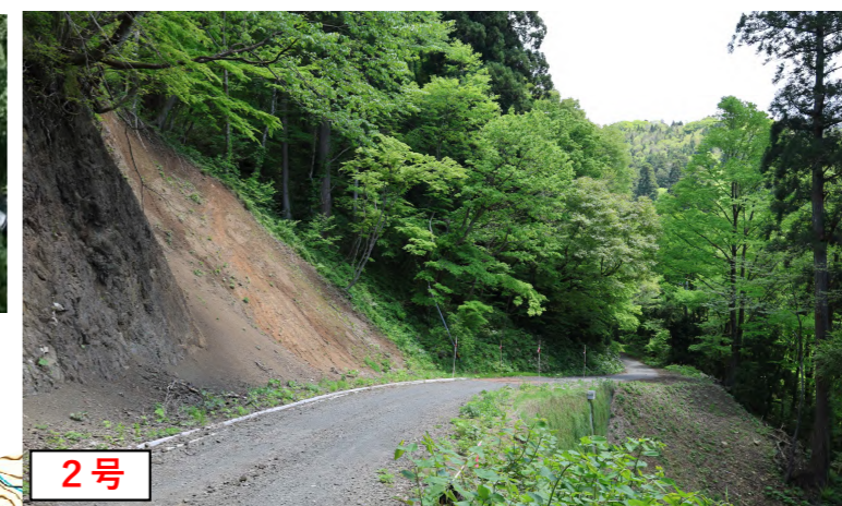
2.7km地点 道路側面崩落 L=34.0m
