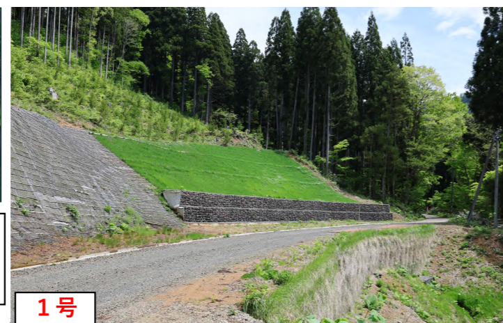
仁別林道起点から1.4km地点 (以降同じ) 道路側面崩落 L=34.0m
