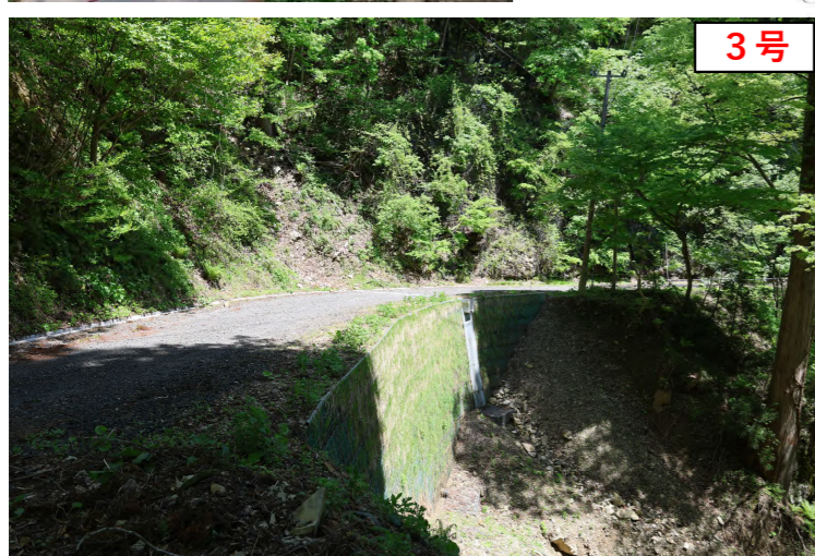
6.8km地点 道路側面崩落 L=26.0m
