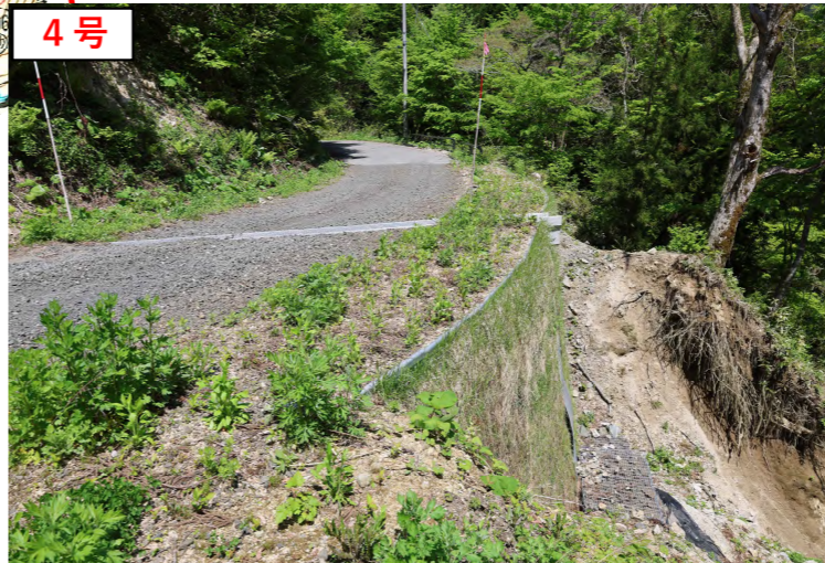
7.7km地点 道路側面崩落 L=12.0m
