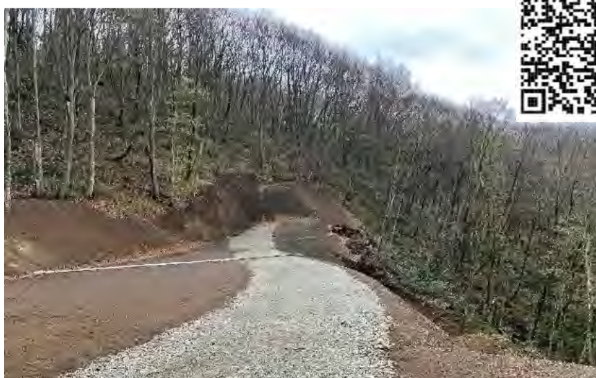
林道作設が進む大台団地
