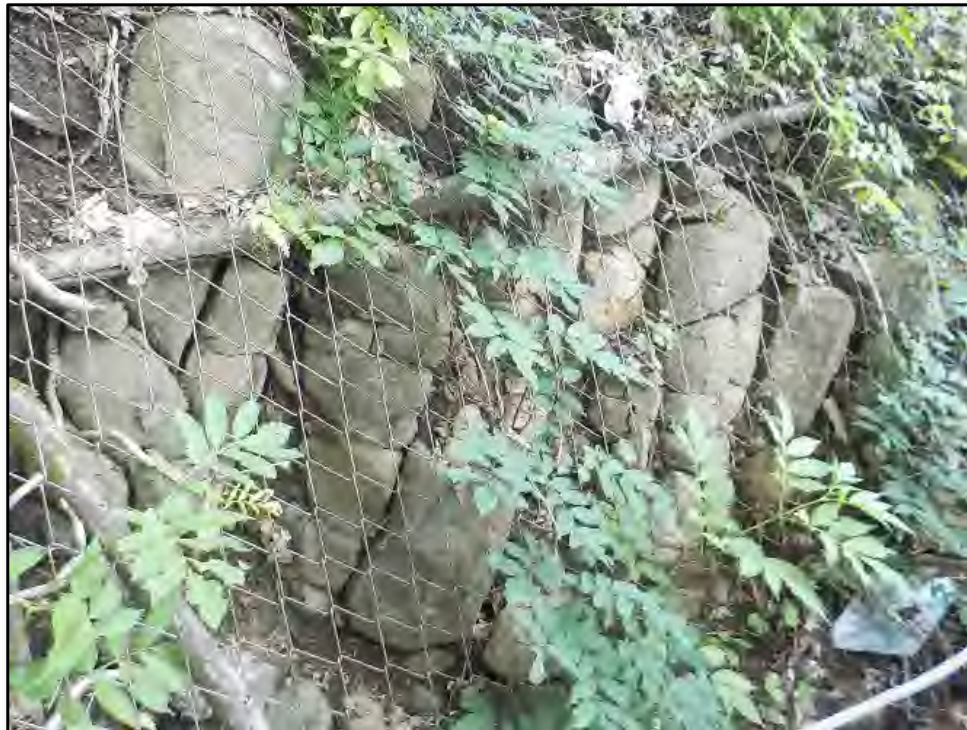
高強度ネットによる落石防止工 環境に配慮し、立木の伐採を最小限にする工法
