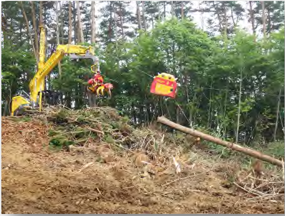
コンビヤード、タワーヤードを用いた集材
