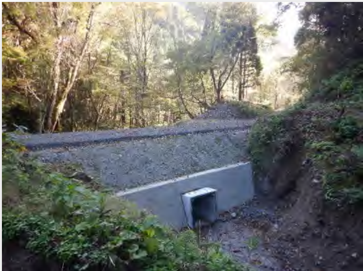
重力式コンクリート擁壁工 ボックスカルバート設置
