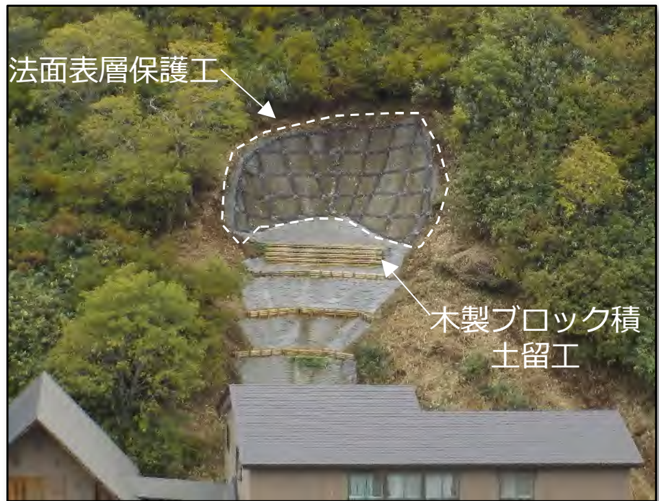
景観性に配慮して施工した法面表層保護工 と木材を利用した土留工
