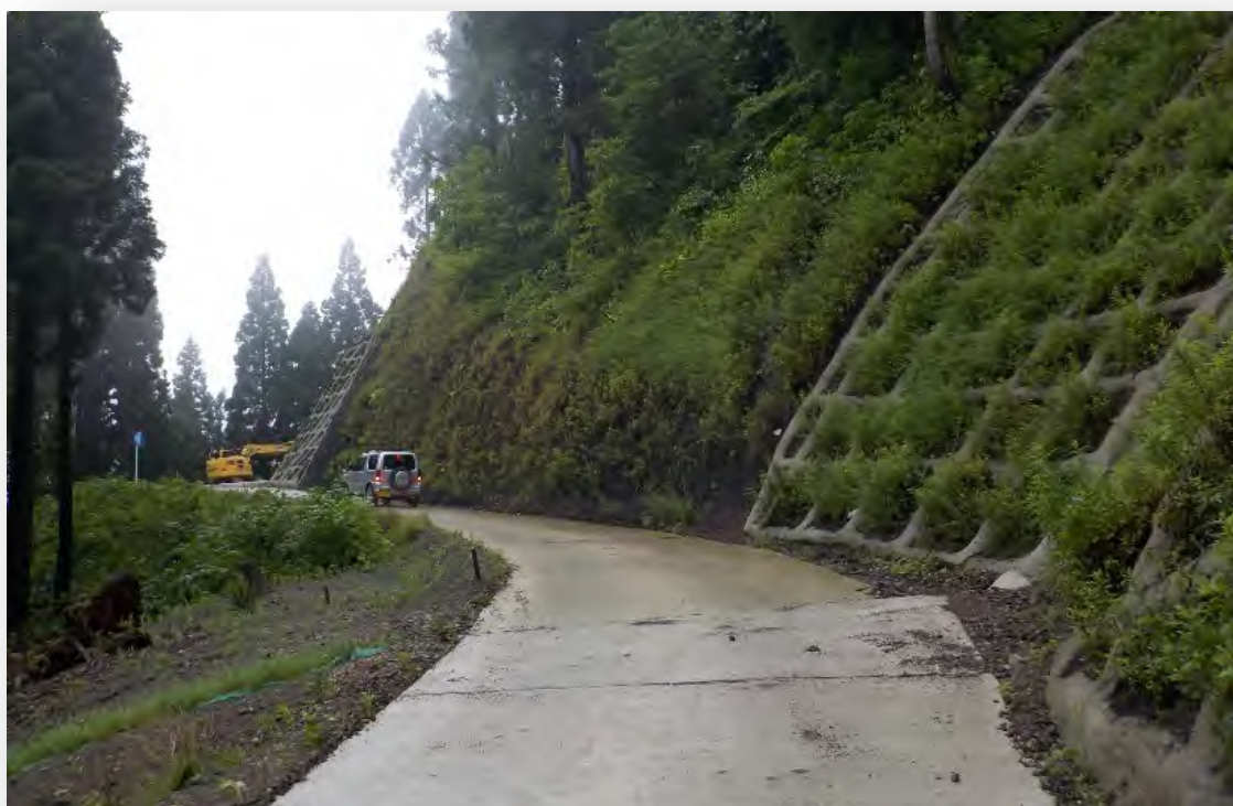
民有林林道の新設工事箇所
