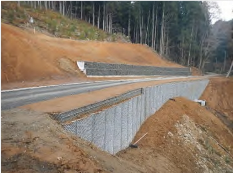
簡易鋼製擁壁工
