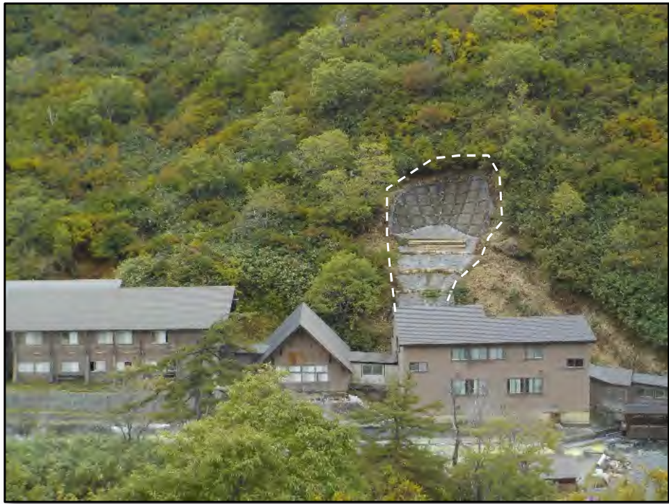
保全対象（温泉施設）と施工箇所
