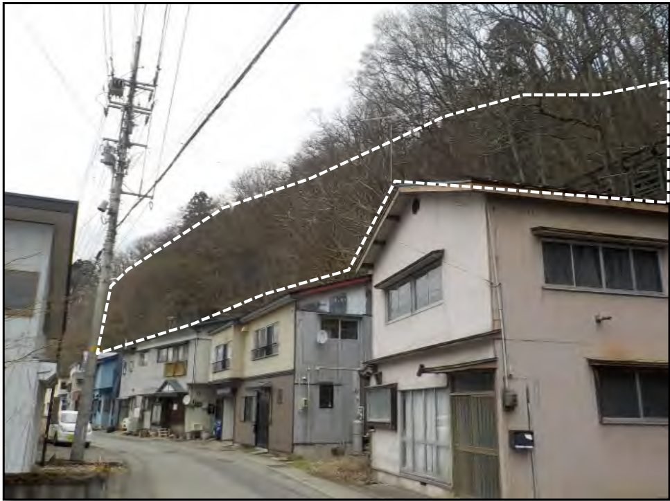
保全対象（民家）と施工箇所
