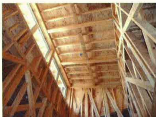
「仙台復興合板」施工状況
