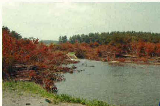
写真4ー水路工破損状況及び 海岸防災林の赤枯れ被害状況
