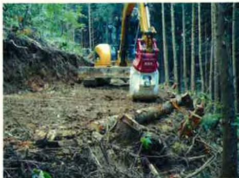
写真1. 土留根株の施工例
