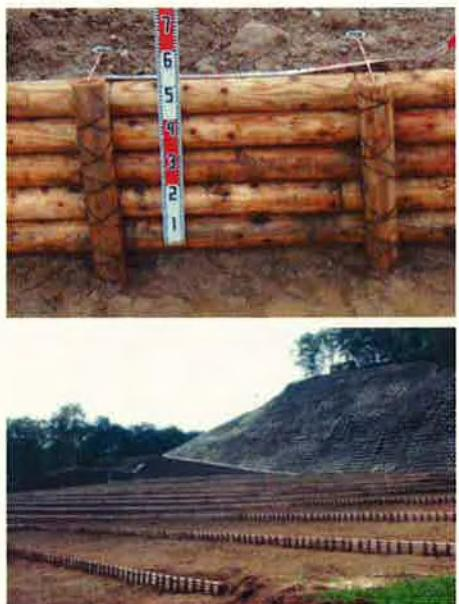
写真-1 丸太柵工等の施工状況
