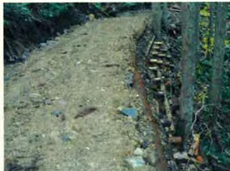
写真2. 丸太組みの施工例
