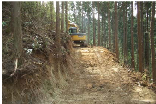
(壊れにくい作業路作設)
